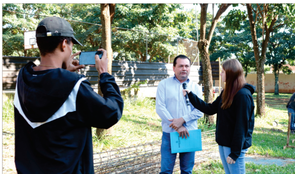
Prefeito Dedê Trovó acompanha o início da construção da quadra coberta na Escola Gabriel Hernandez e participa de entrevista conduzida pelos alunos, com foco na nova estrutura. - Foto: JD.
